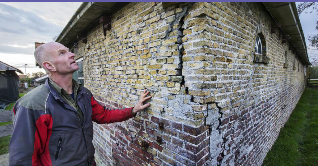
In Fryslân zien we dat het veen op termijn zal verdwijnen als we doorgaan op de huidige weg. Dit heeft o.a. op effect op de funderingen van huizen en wegen. Fotograaf: Rens Hooyenga
