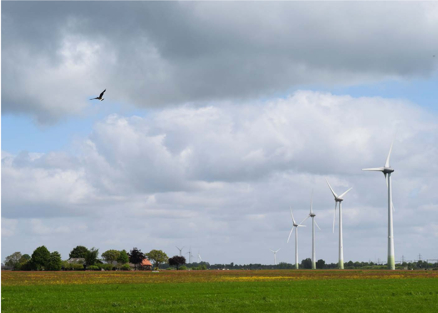
Foto van de bestaande windturbines in het gebied. Door ontwikkelingen in de toekomst te clusteren en landschappelijk in te passen kunnen we bestaande kwaliteiten van het landschap behouden
